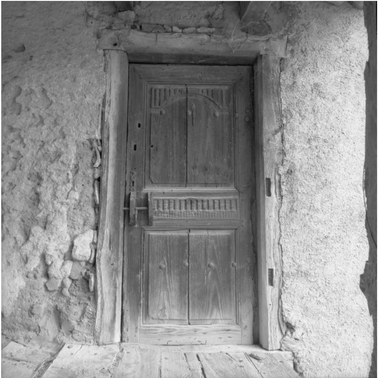
Porte de la chambre à l'étage de la remise située en retour du logis ancien (encadrement en bois chanfreiné).
