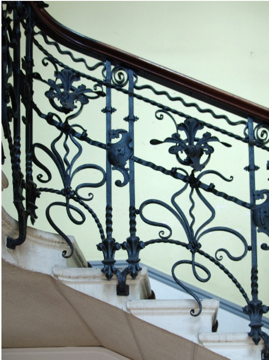
Ferronnerie du grand escalier
