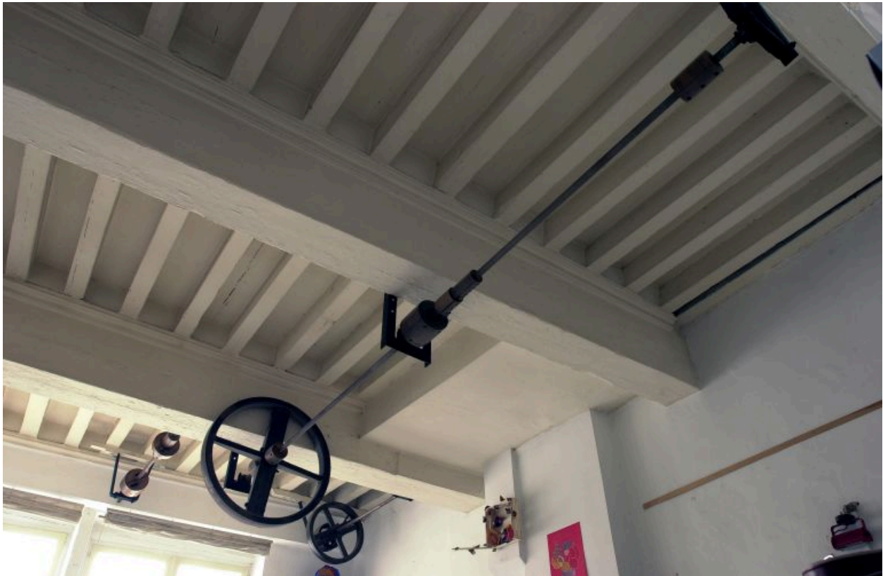
Bâtiment 3, 3e étage, pièce ouvrant sur la cour I et aménagée en atelier, mécanisme de transmission des anciennes machines
