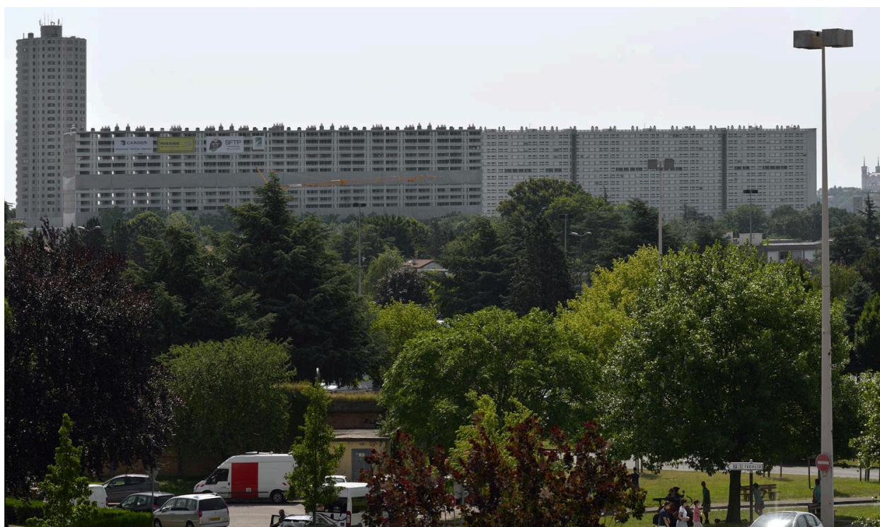
Vue d'ensemble de la barre des mille avant démolition
