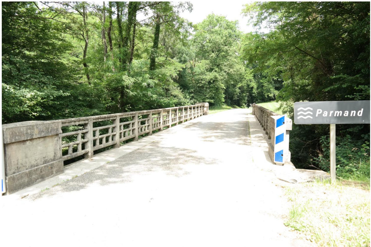
Pont du Parmand 2, vue de la chaussée
