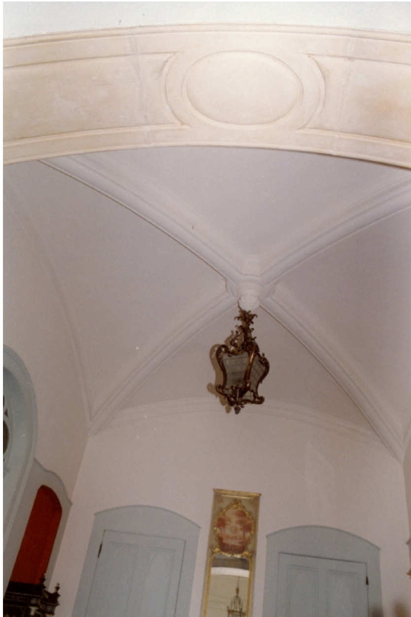
Voûte d'arêtes à l'intérieur d'une tour d'angle
