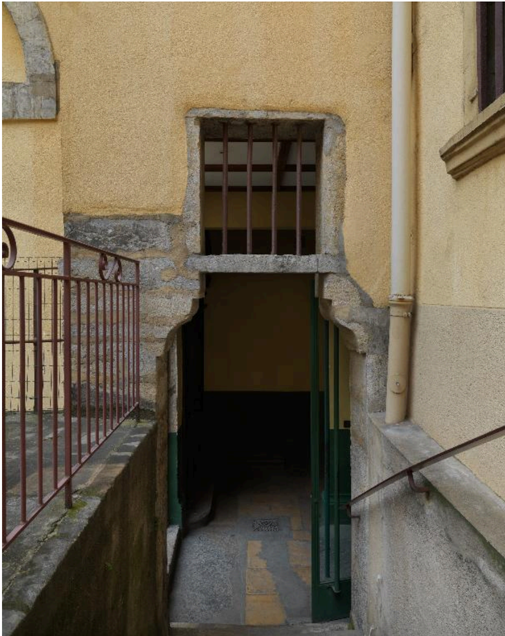
La cour : depuis la terrasse vers l'allée en passant par la cage d'escalier ouest
