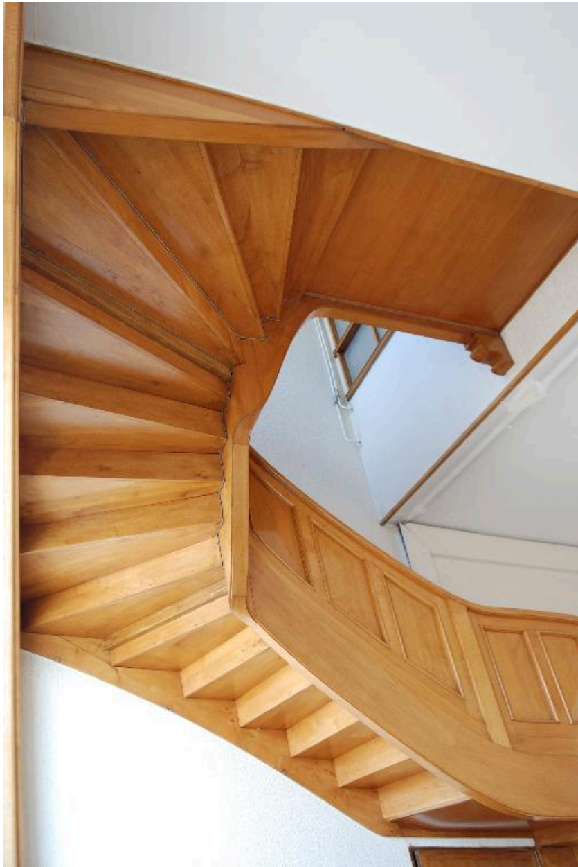
Escalier desservant l'appartement du proviseur, vu depuis le bas
