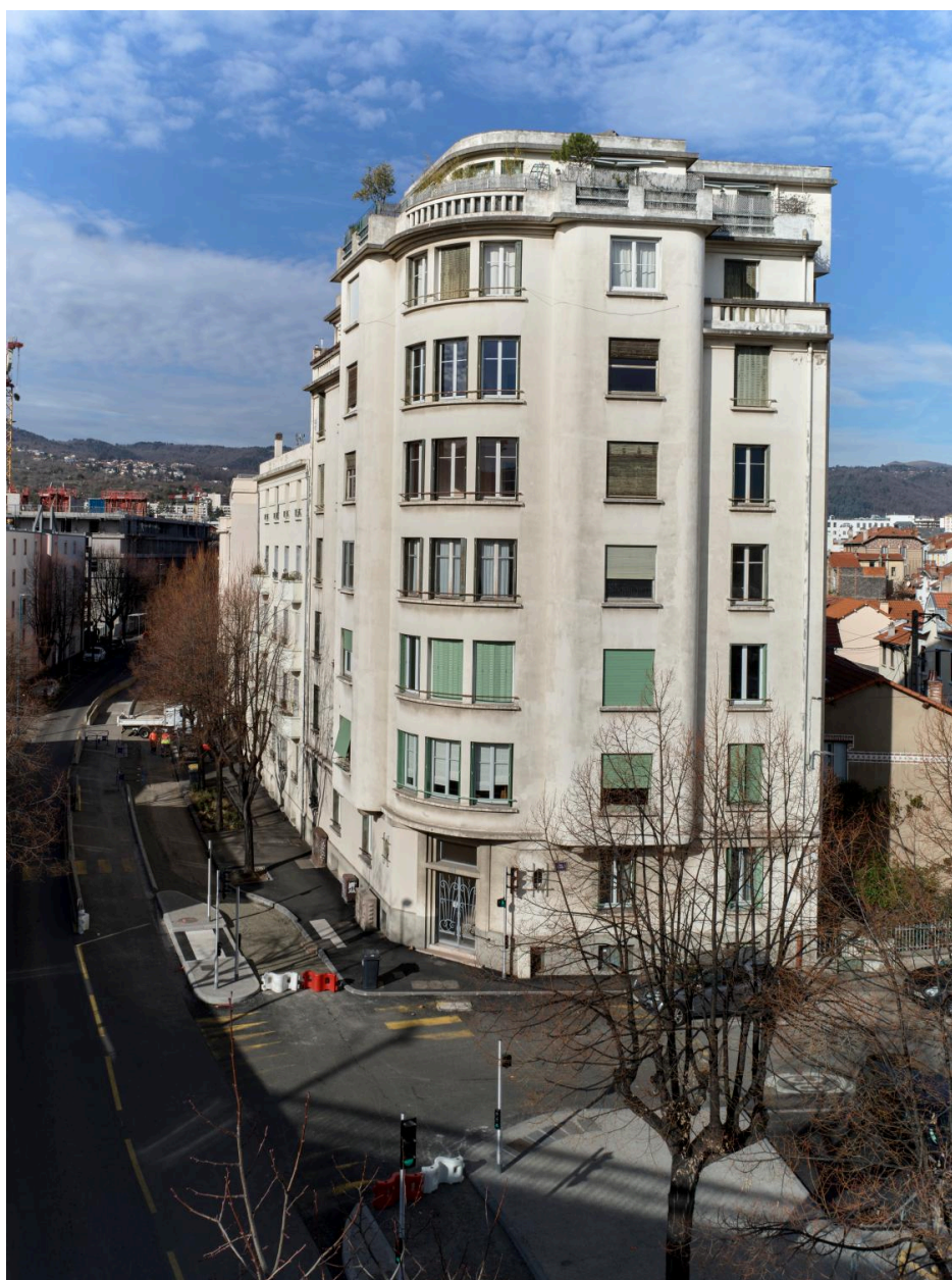
Façade d'angle rue Ledru et boulevard Cote-Blatin
