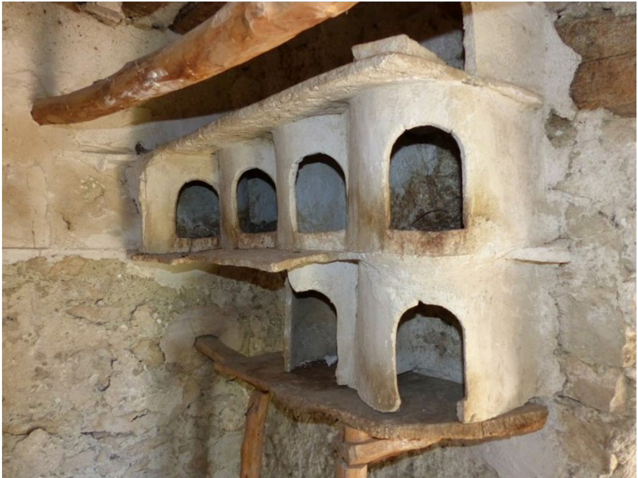
Rez-de-chaussée surélevé. Angle sud-est, boulins.
