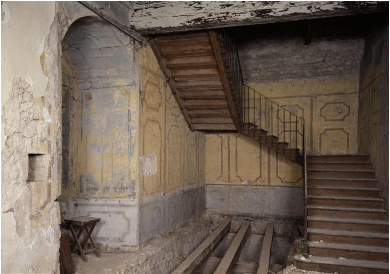
1er étage, pièce gauche, côté est : vestiges de peintures murales.
