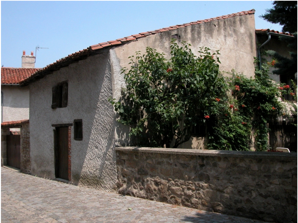
Le Bourg, impasse du Prieuré. Dépendance agricole (de la maison Bégonnet, 1999 AD 126) (1999 AD 212).
