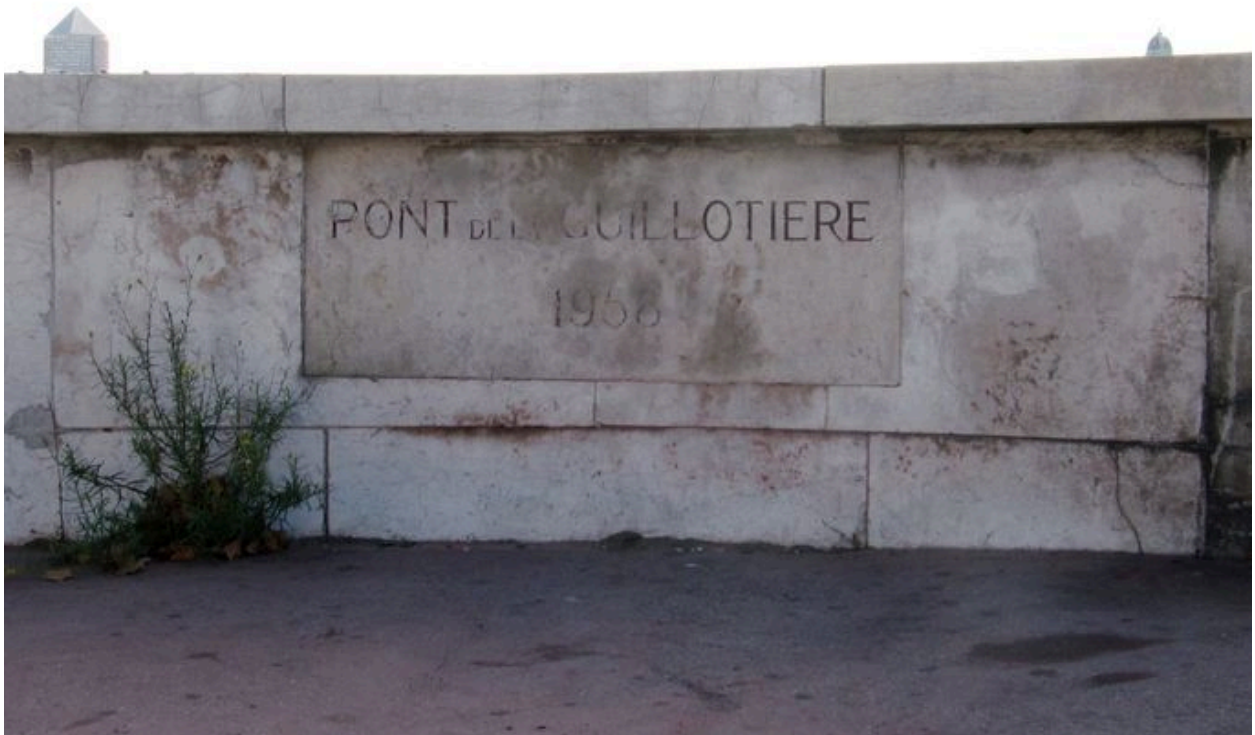
Parapet, vue de détail : inscription (depuis la rive droite)
