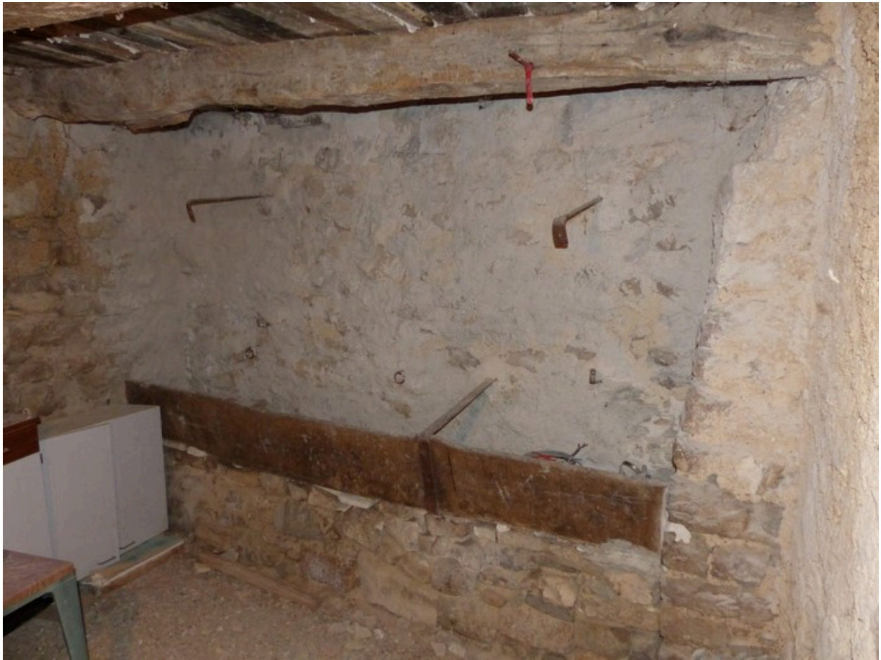
Rez-de-chaussée, étable est. Mur sud, mangeoire.
