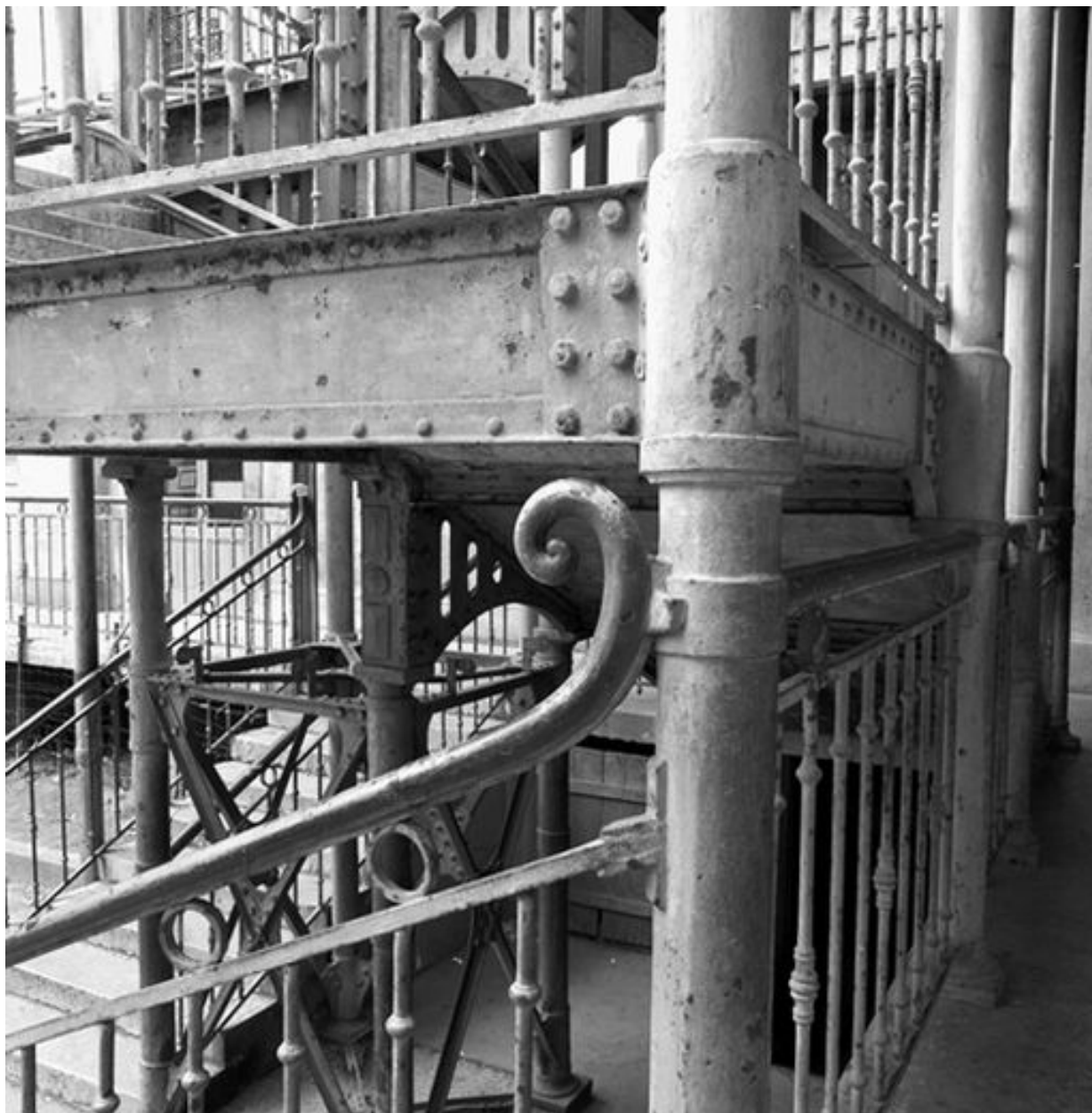
Ecole Ozanam, escalier hors-oeuvre de la cour : détail
