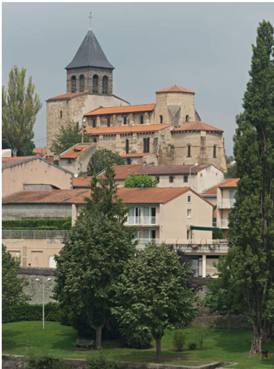
Eglise et village, vue au sud.
