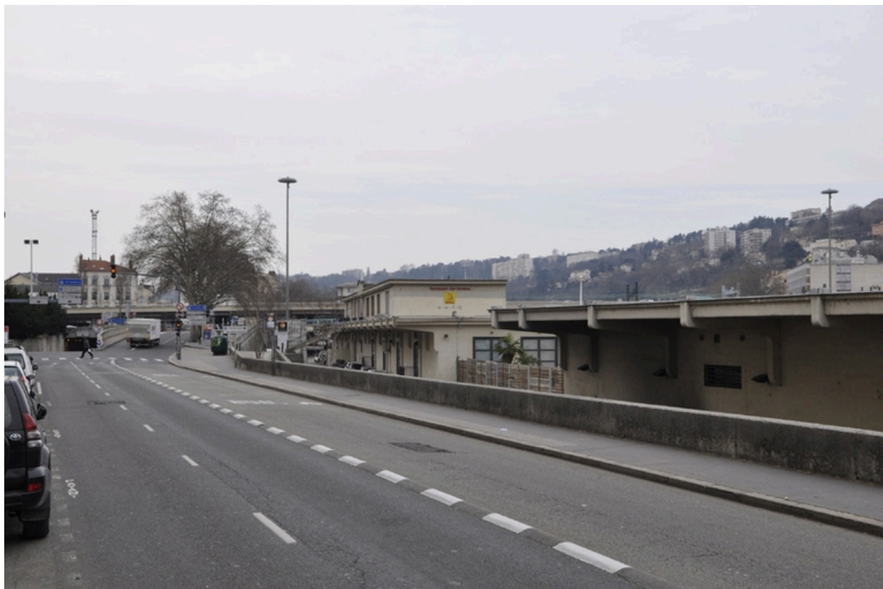
Vue nord du site du quai Maréchal Joffre
