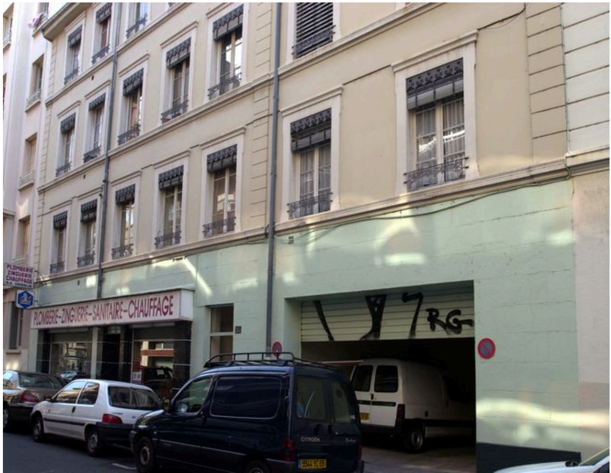
Elévation antérieure, vue partielle
