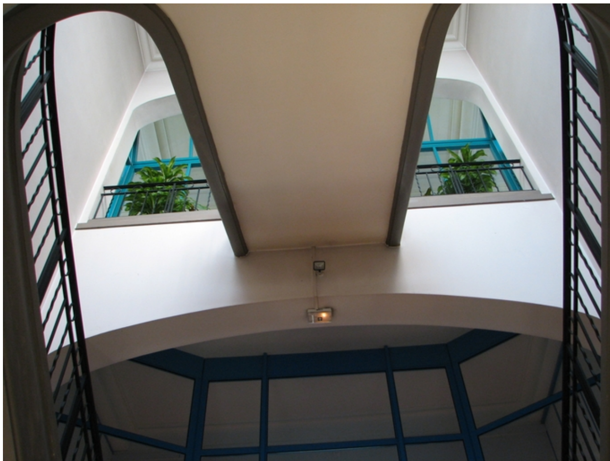
Escaliers des grands bureaux
