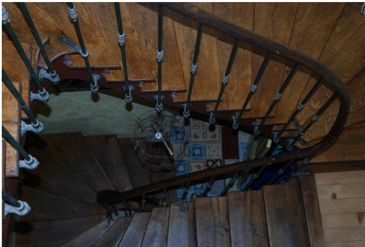
Vue intérieure : escalier en bois.
