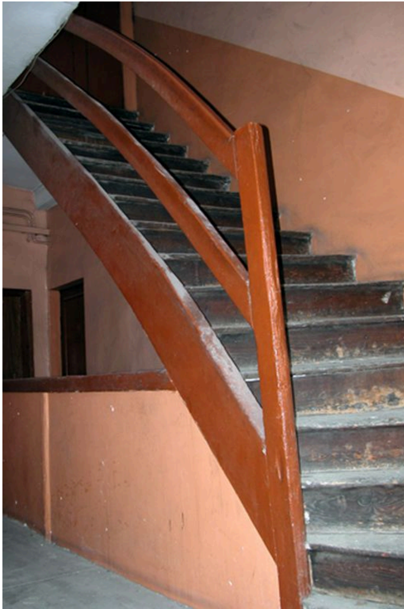
Vue de la montée d'escalier du dernier niveau
