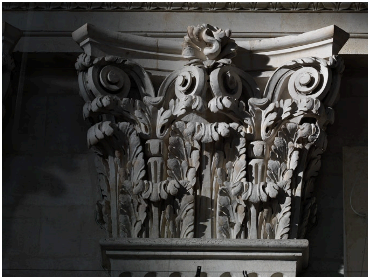
Détail d'un chapiteau de pilastre
