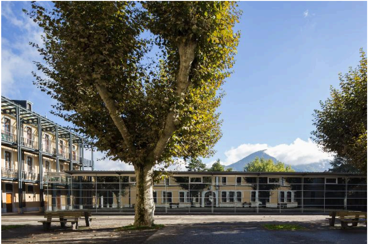
Façade sur cour 1.
