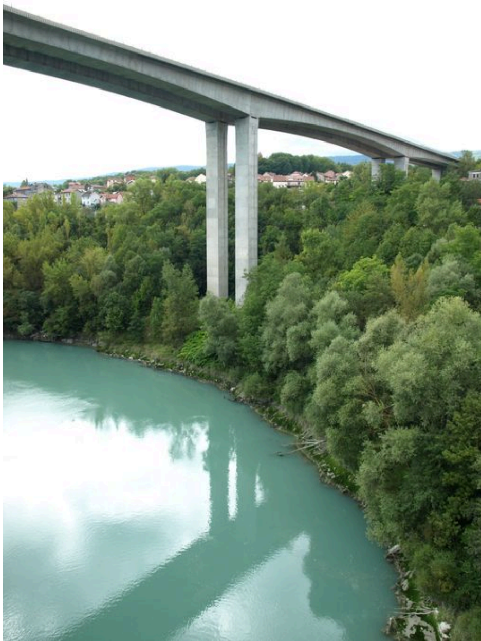
Vue partielle, face aval (depuis la rive gauche)
