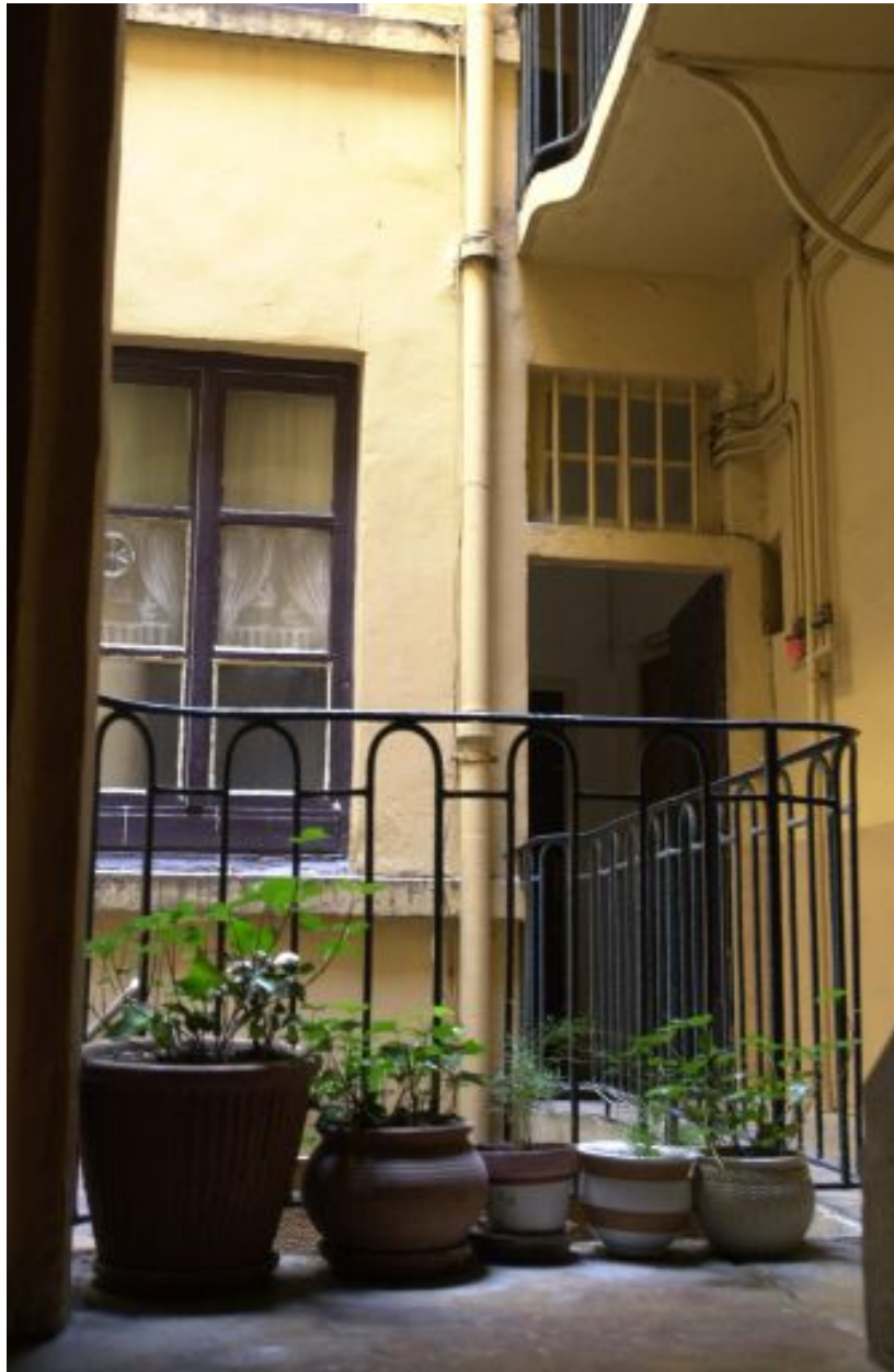
Escalier, palier du premier étage
