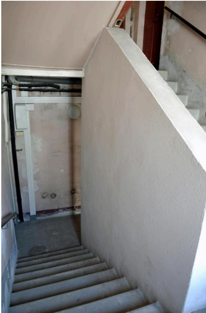
Vue de l'escalier, première révolution en béton
