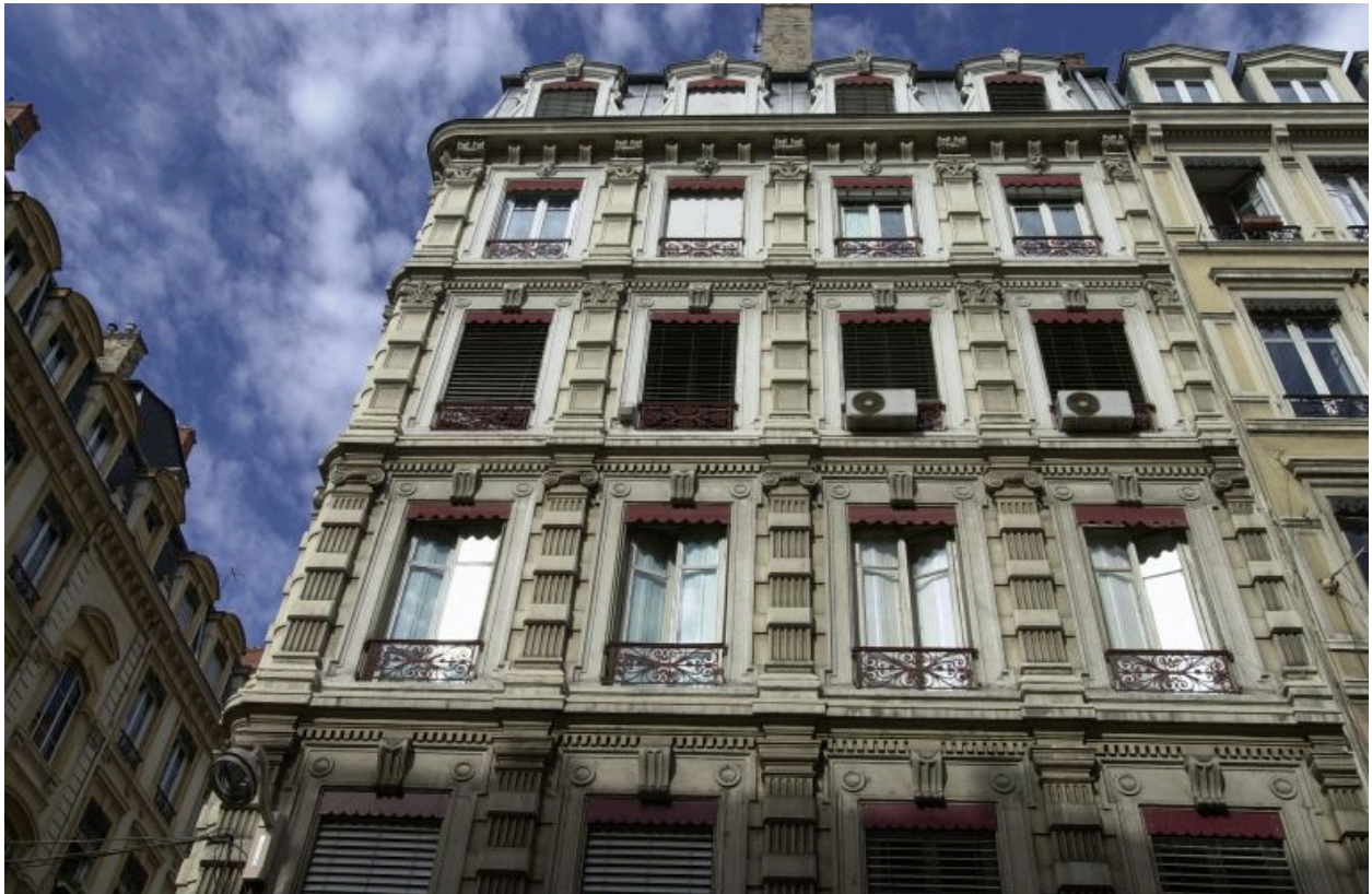
Façade principale rue de Brest, vue par-dessous
