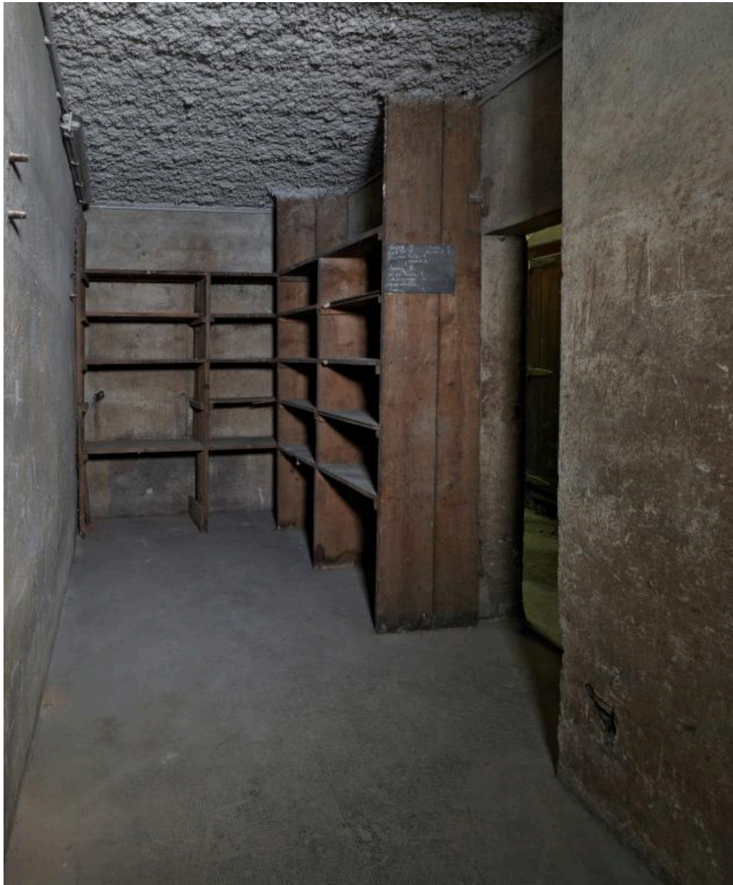
Brasserie La Taverne : sous-sol, lieu de stockage
