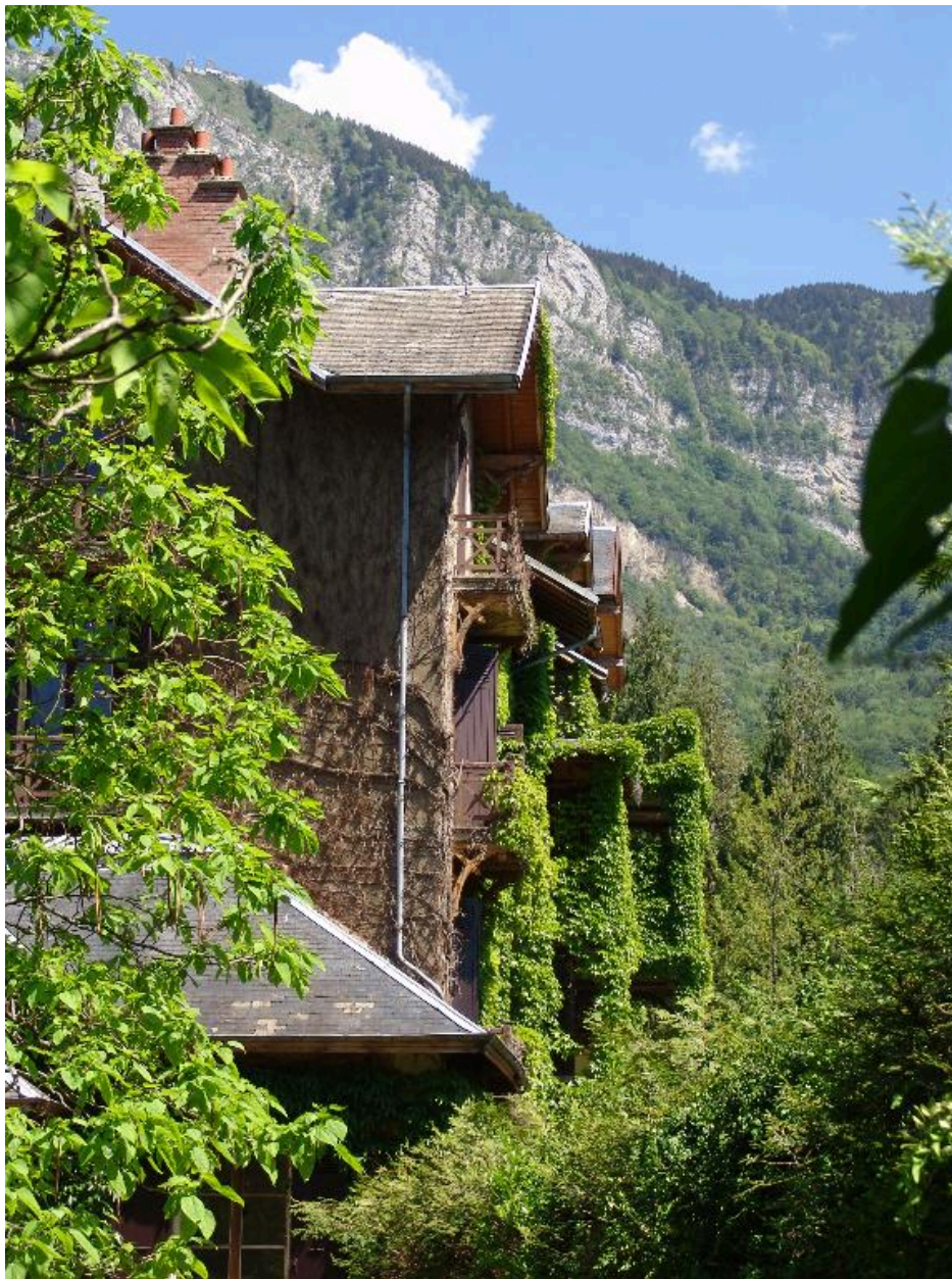
Logement des soeurs : détail sur les parties hautes
