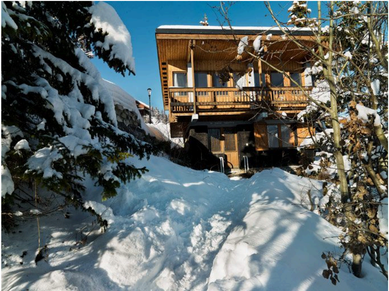
Vue rapprochée de l'élévation antérieure
