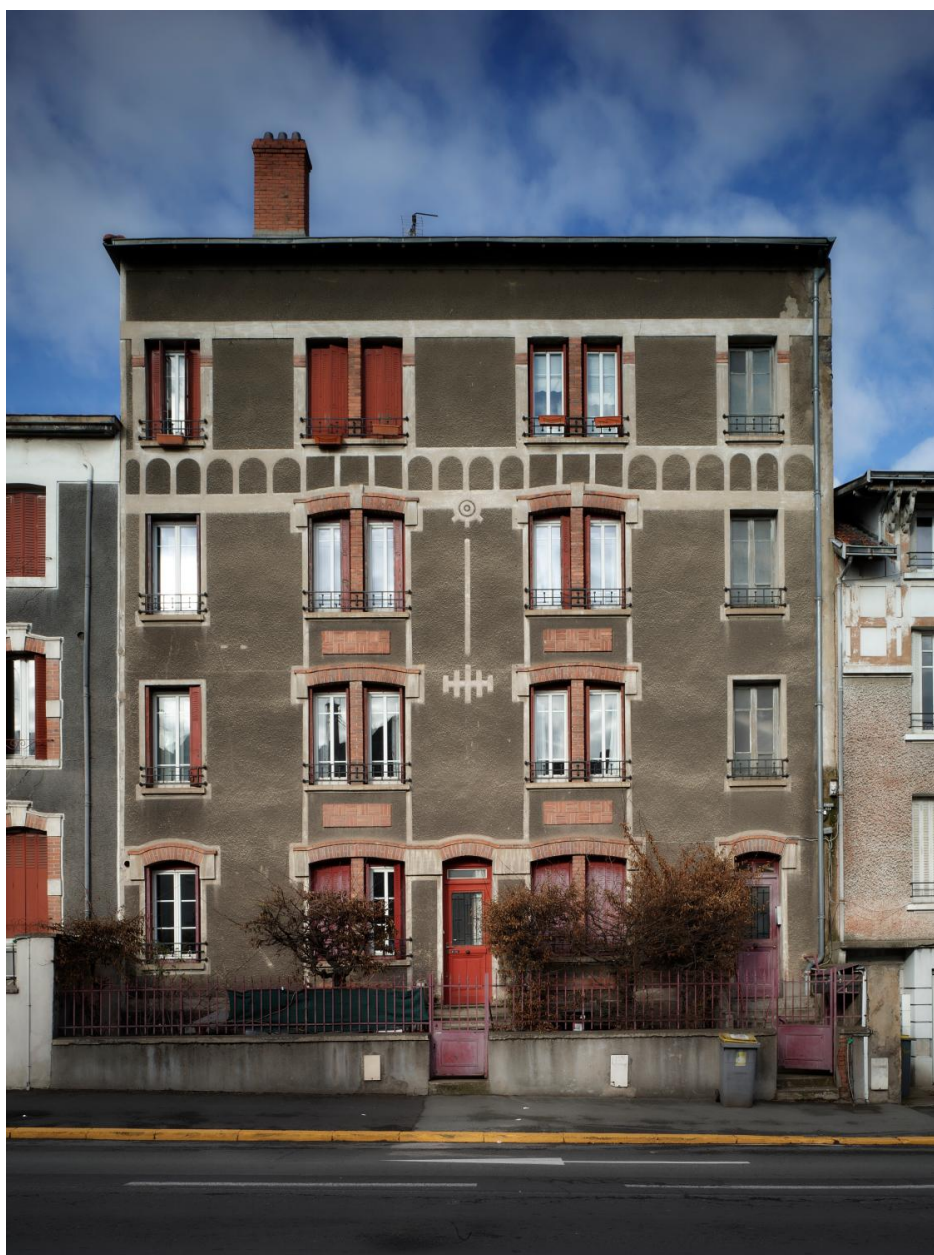
Façade sur le boulevard Fleury
