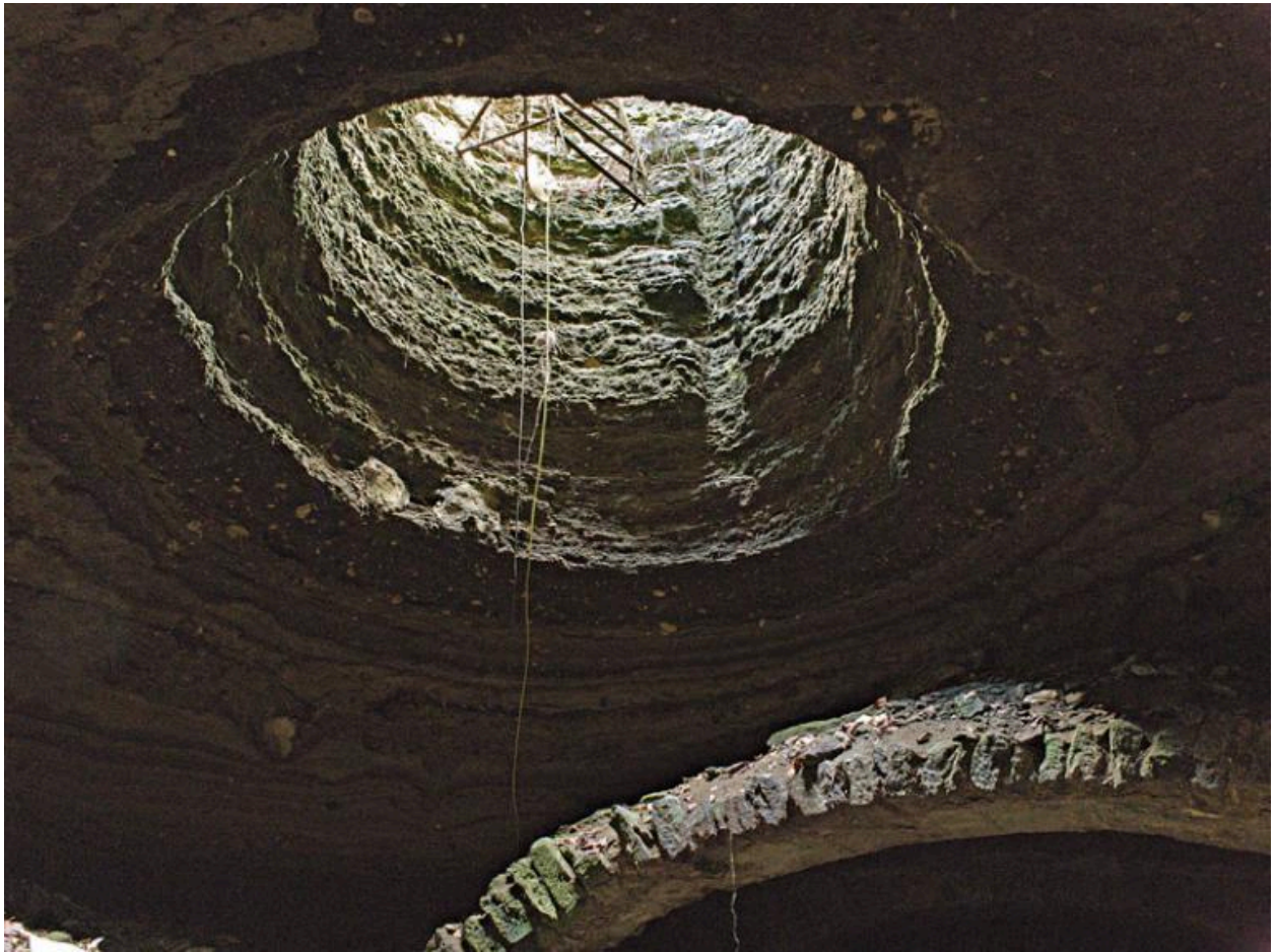
Hôtel-Dieu de Clermont-Ferrand. L'hôtel-Dieu, les galeries souterraines, galerie sud-ouest, puits de manutention et d'aération.
