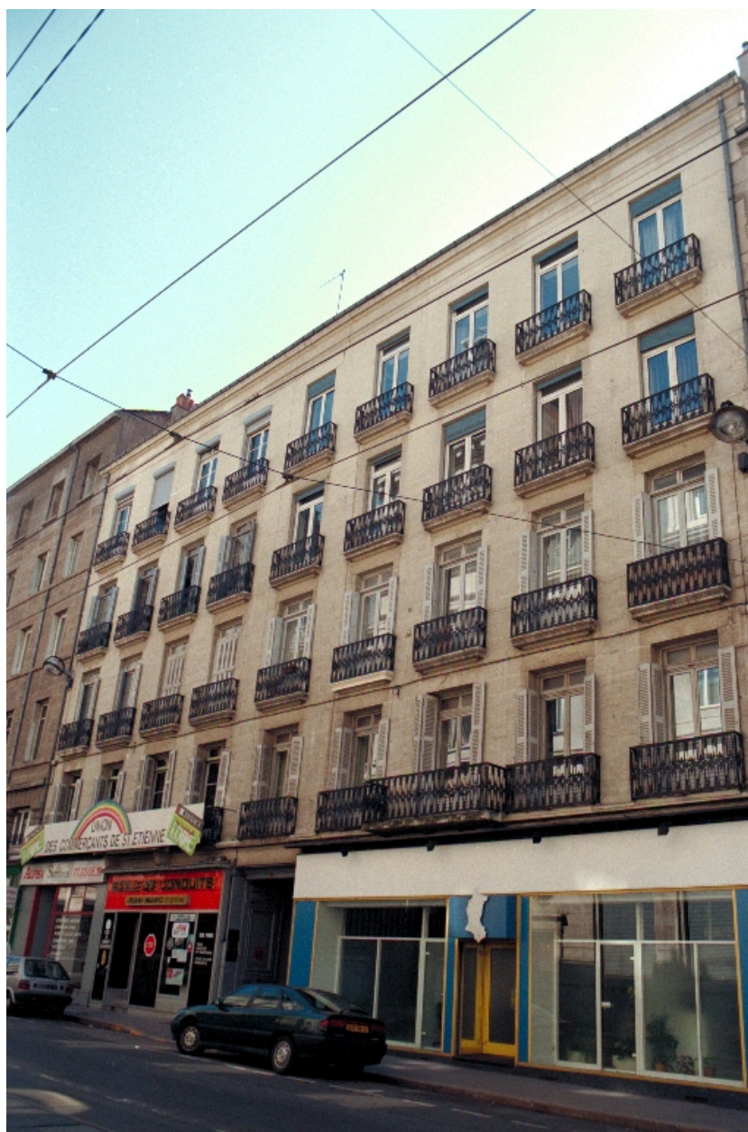
Façade principale, rue Charles-de-Gaulle
