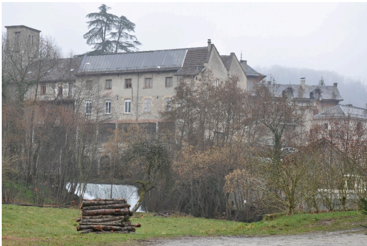
Vue générale du site avec l'usine, le logement patronal et le bâtiment administratif, facade nord
