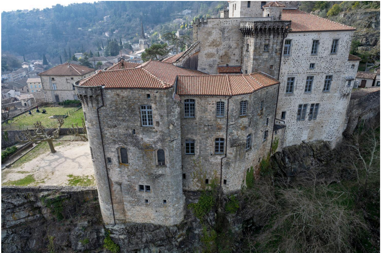
Elévations nord, vue aérienne
