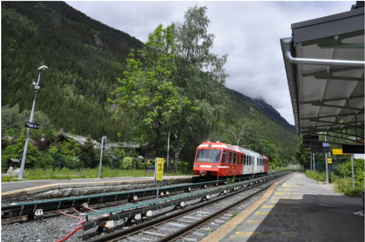
Vue de la voie ferrée depuis le quai de la halte des Tines
