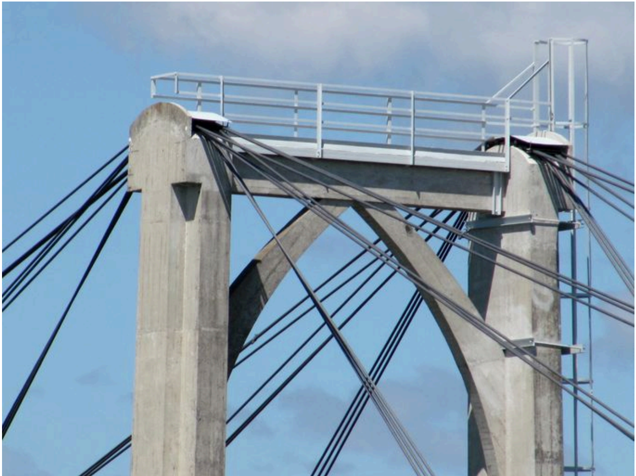
Passerelle entre les deux mâts du pylône de la rive droite
