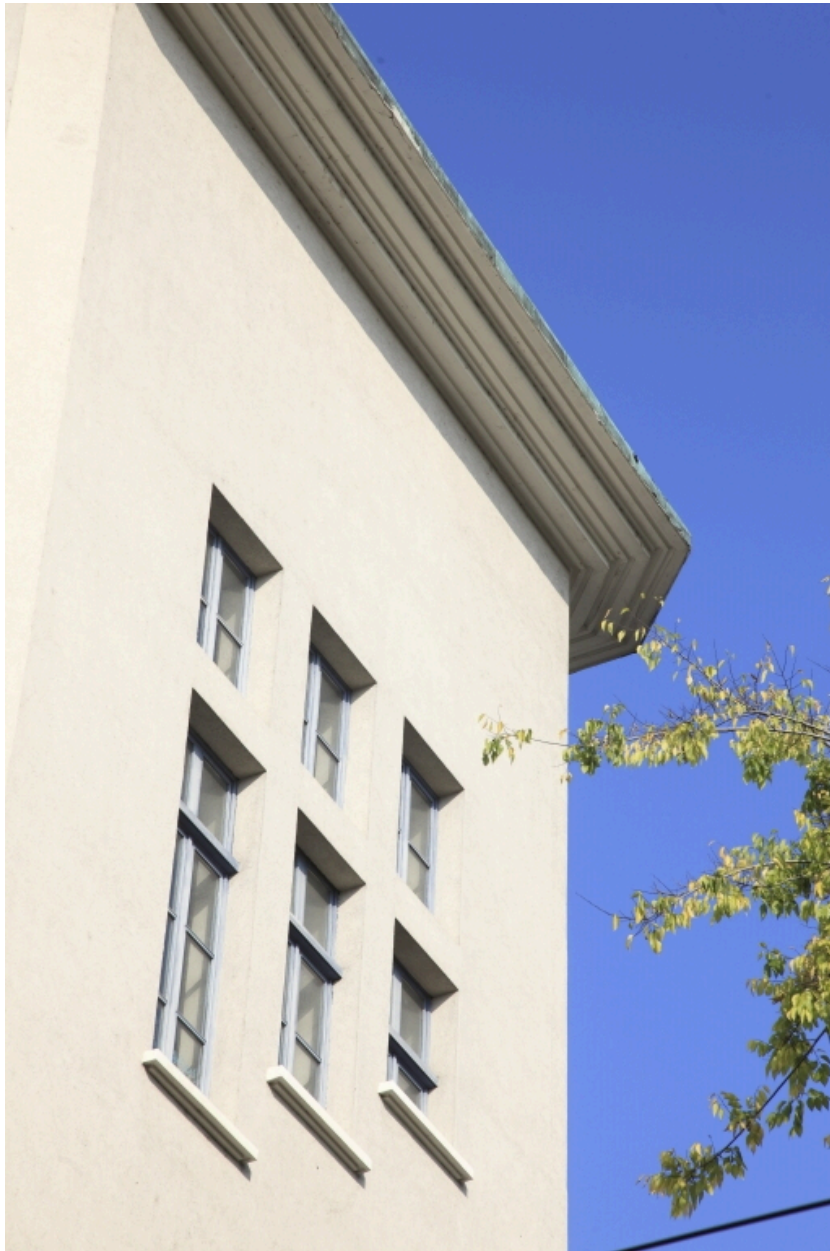
Le bâtiment principal. Détail de l'attique.
