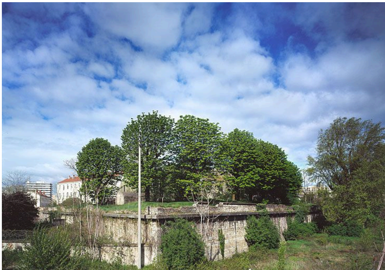
Angle de 60° du bastion 2
