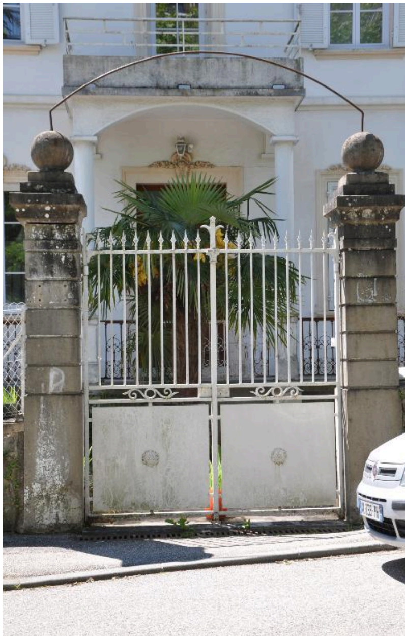
Détail sur l'ancien portail de la villa
