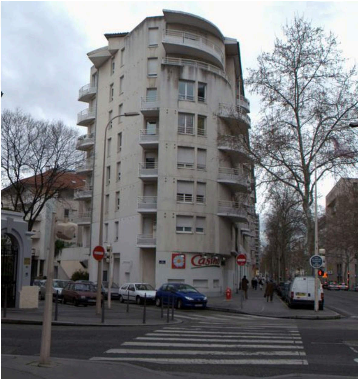
Détail de l'immeuble à l'angle des rues Abbé-Boisard et cours Gambetta
