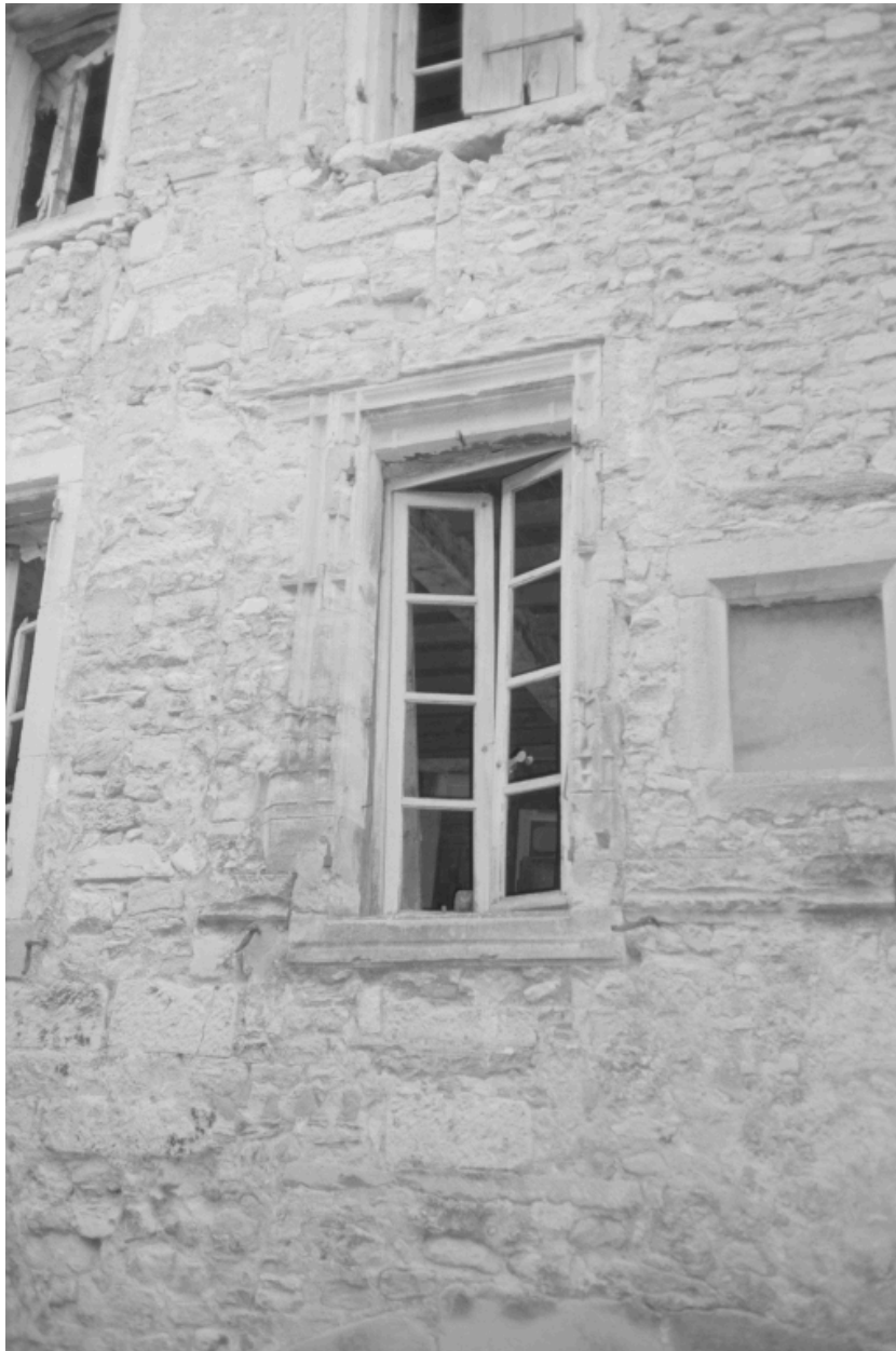
Façade sur rue, détail : fenêtre du 2e étage, anciennement à croisée.
