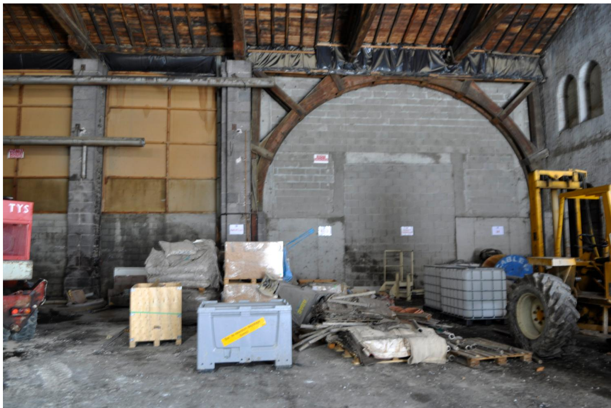
Vue de l'intérieur des ateliers
