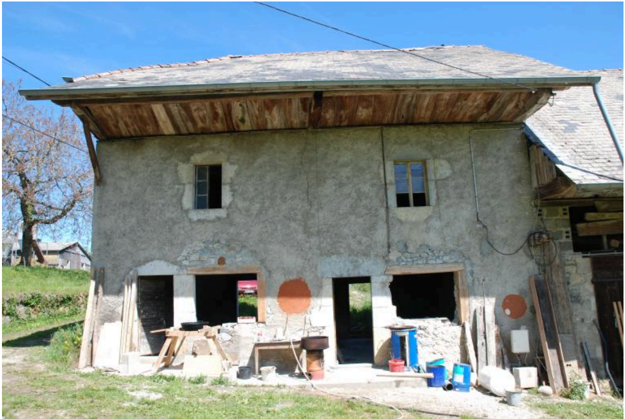
Vue de l'habitation.
