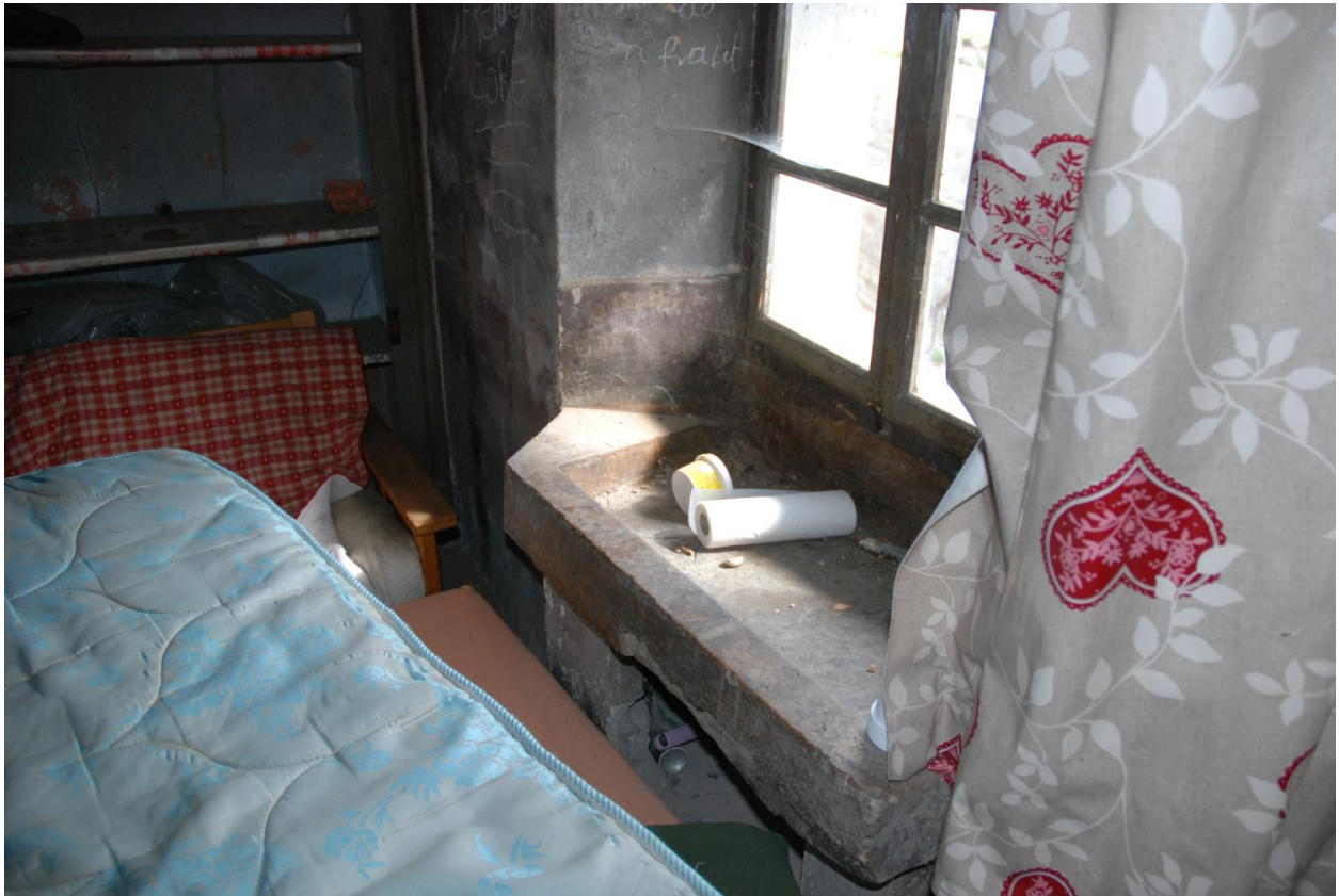
Cellier viticole, dit sarto (2018 E3 1883). Vue intérieure de la cuisine : évier.
