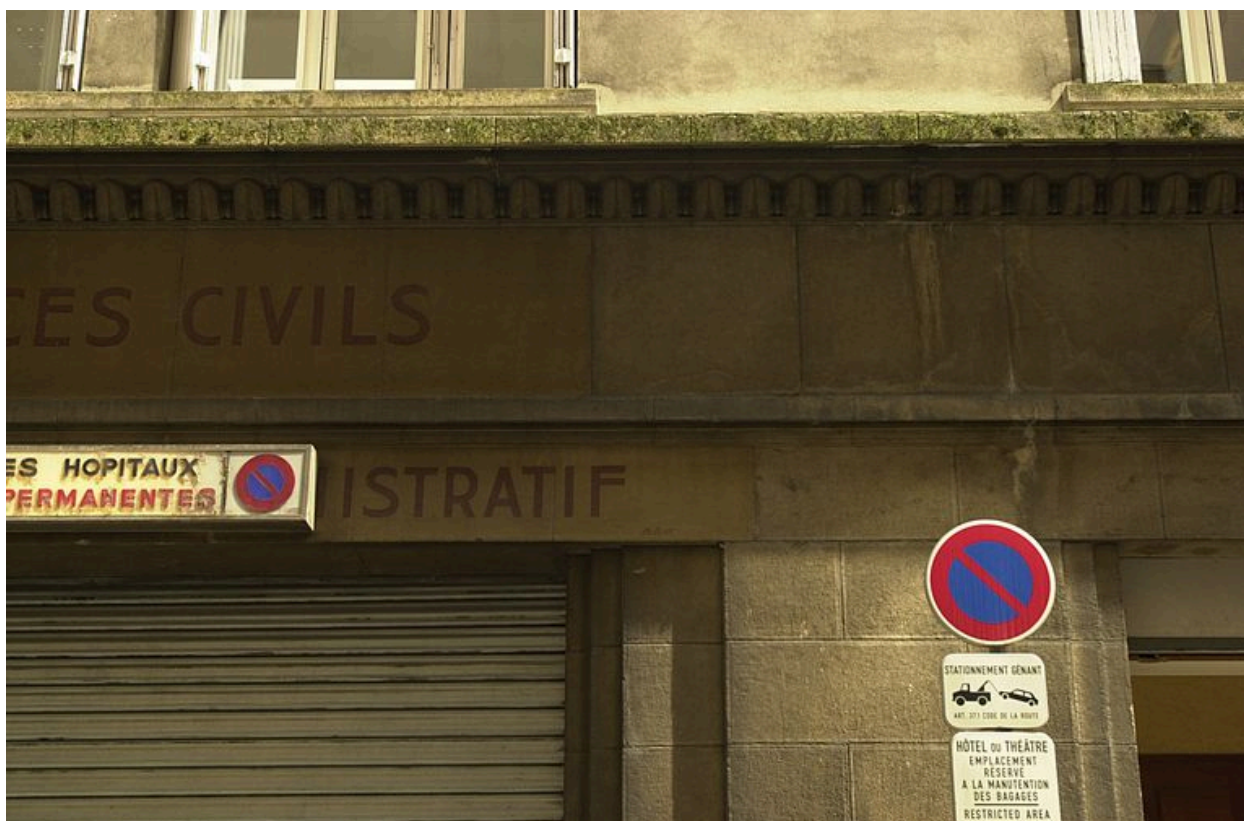
Garage n°5 rue de Savoie (détail de la signature de l'inscription)
