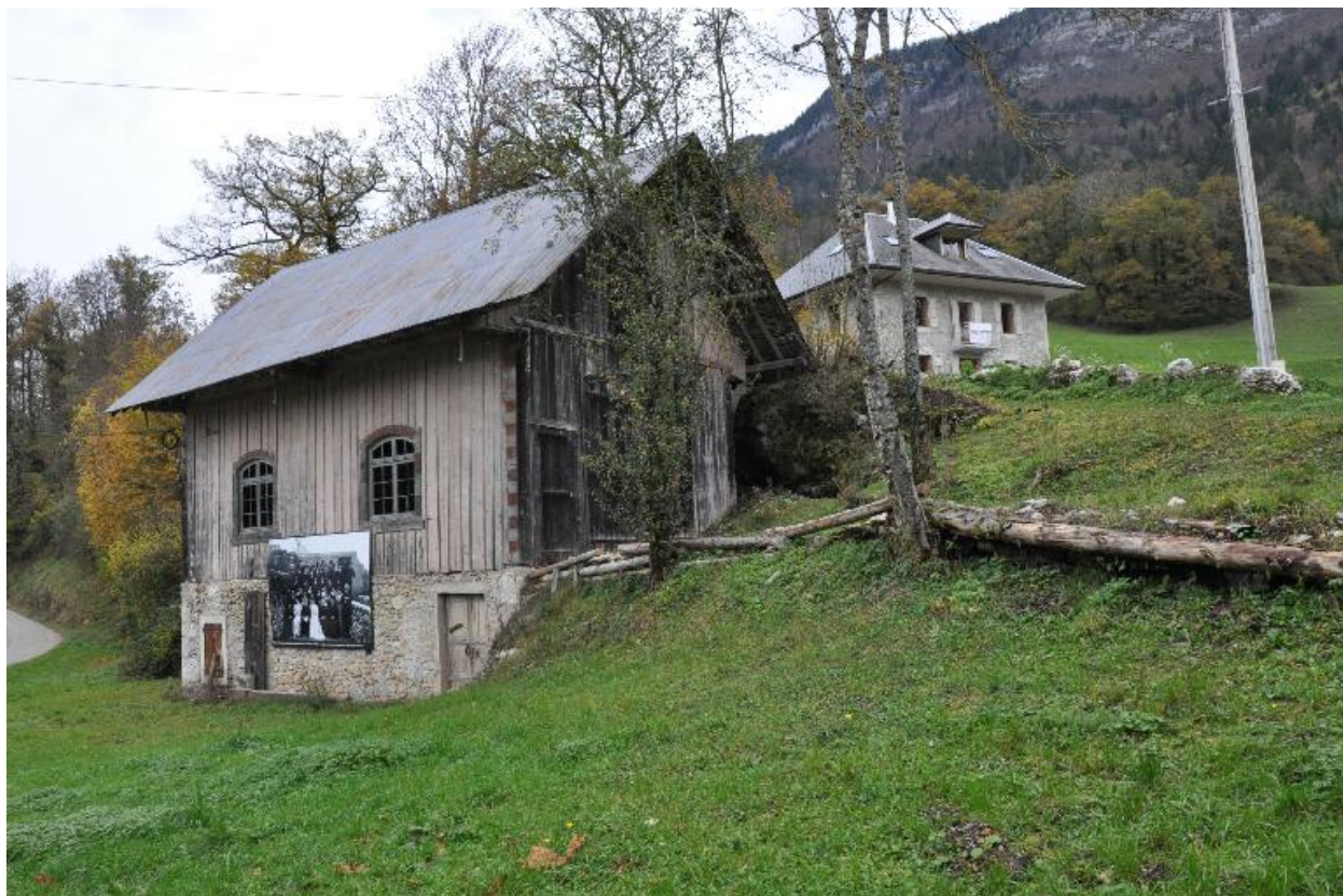
Vue générale de la centrale.
