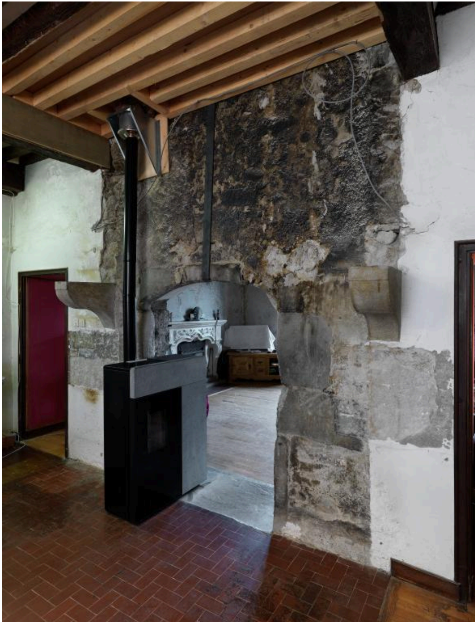
Vue intérieure : cheminée du 1er étage.
