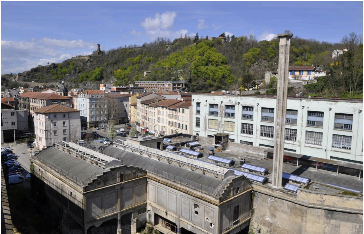
Vue d'ensemble avant travaux
