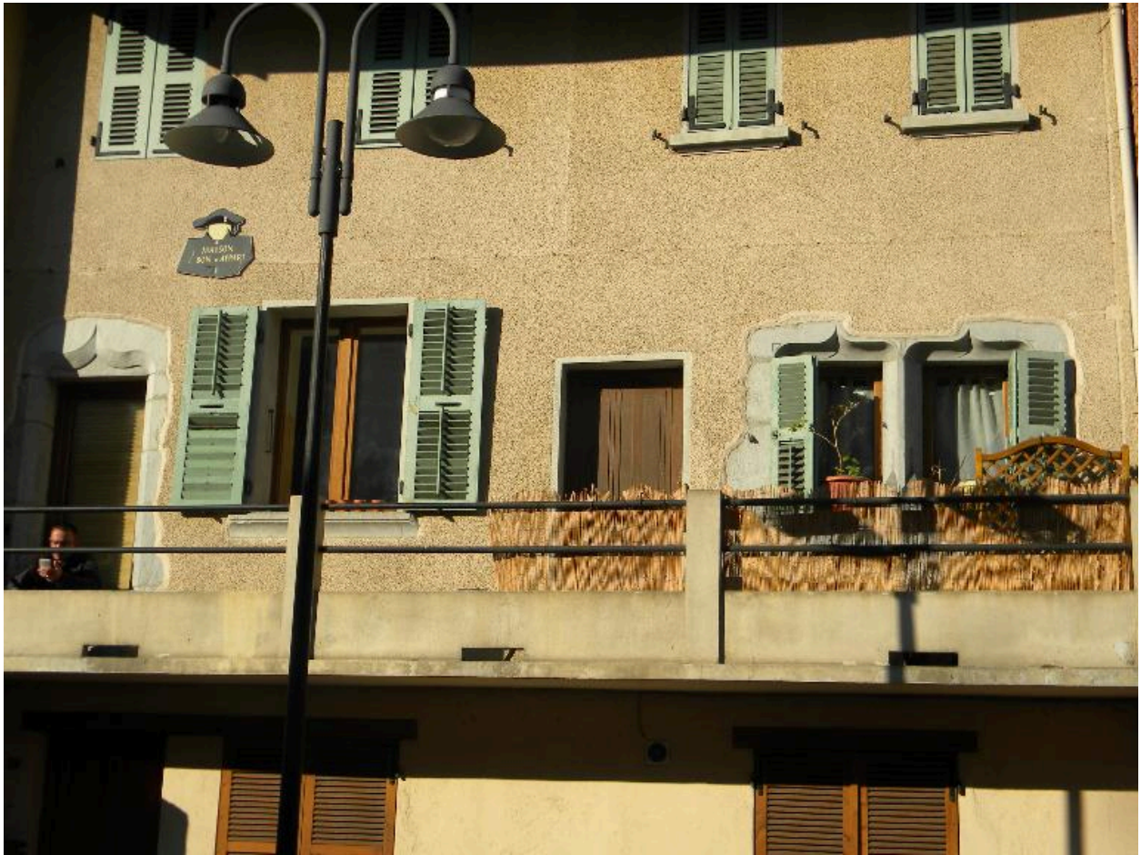
Détail d'une façade avec des encadrements en accolade.
